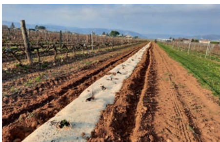
Réalisation d'un chantier de plantation de haie suite à un accompagnement par un conseiller.
